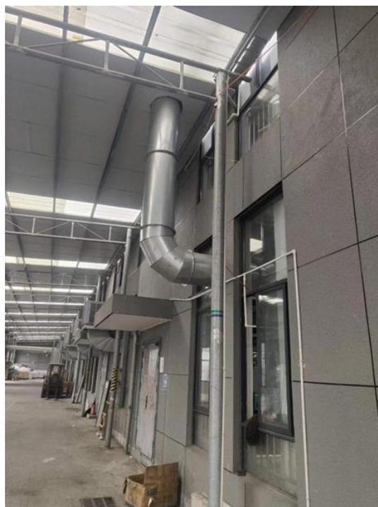
图 3.1-2 注塑废气收集管道
