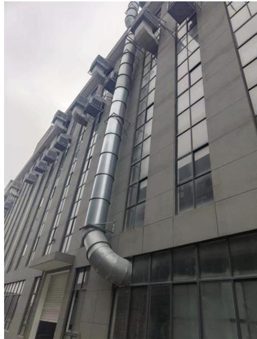
图 3.1-6 印刷废气排气筒 DA002
