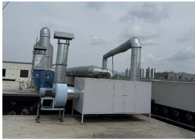
图 3.1-3 注塑废气处理设施及对应排气筒 DA001
