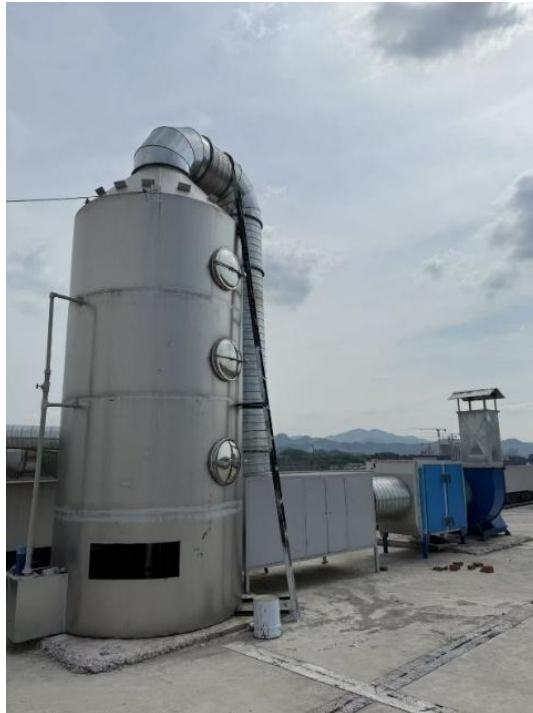
图 3.1-13 水性漆废气处理设施 TA002
