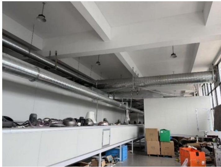
图 3.1-7 油性喷漆线对应废气收集管道
