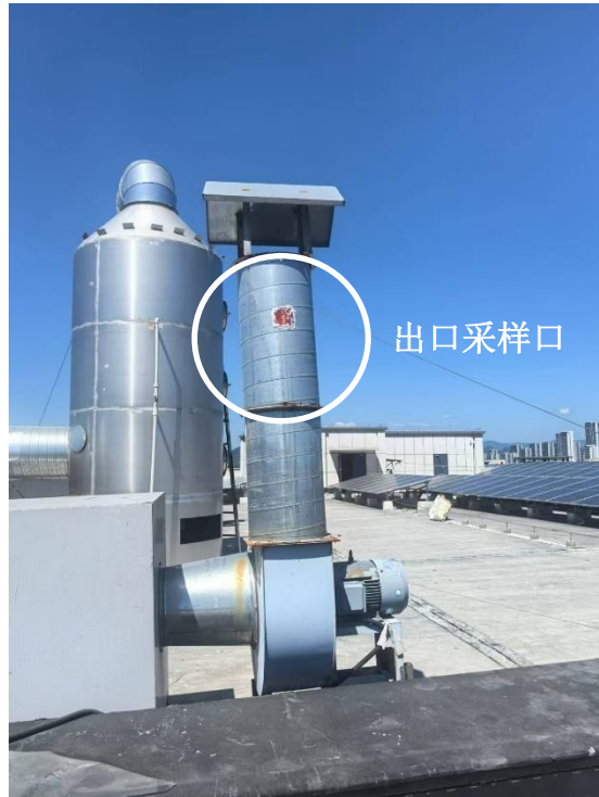
图 3.1-4 废气排气筒 DA001 出口采样口
