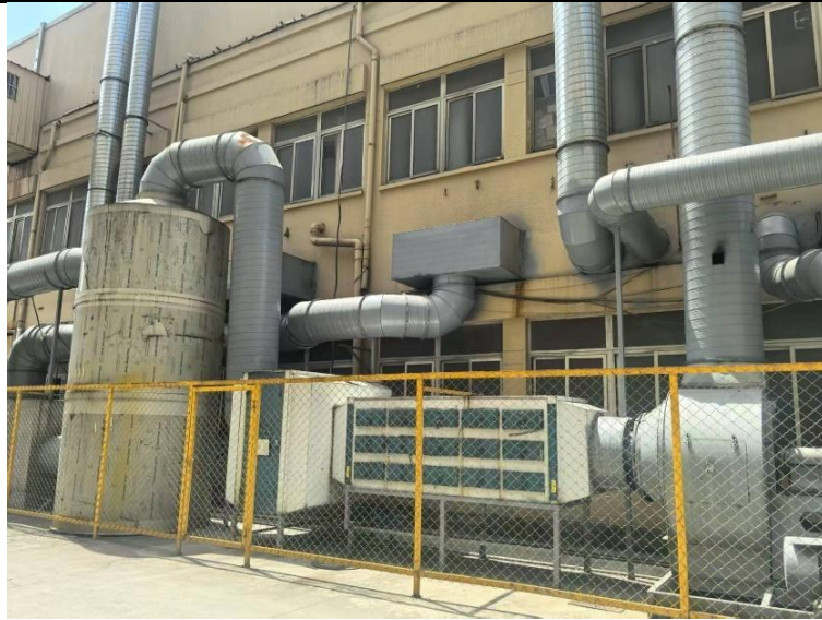
图 3.1-9 涂装#1 废气对应废气处理设施
