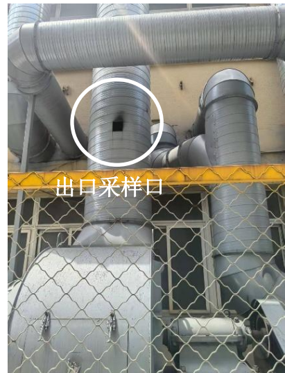
图 3.1-10 涂装#1 废气处理设施进口及出口采样口
