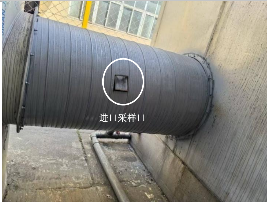
图 3.1-12 涂装#2 废气处理设施进口采样口
