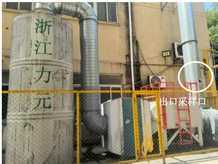
图 3.1-11 涂装#2 废气对应废气处理设施
