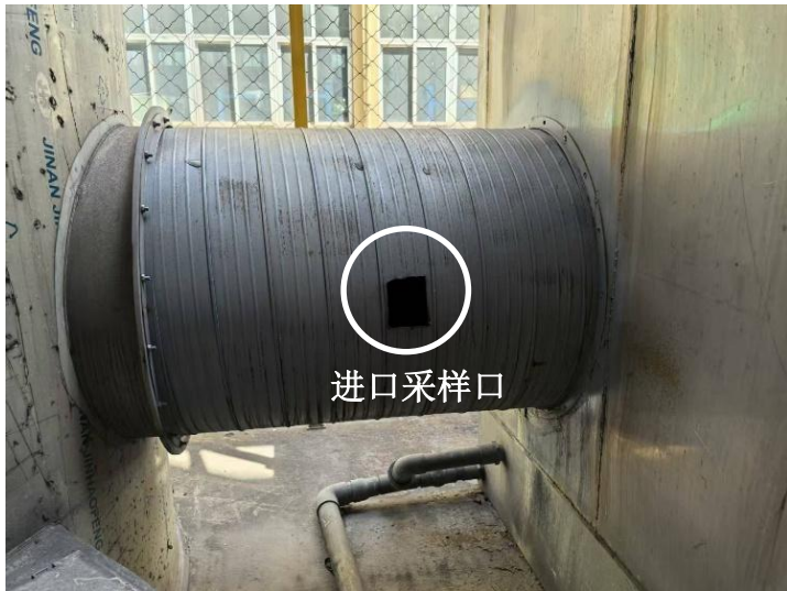
图 3.1-10 涂装#1 废气处理设施进口及出口采样口
