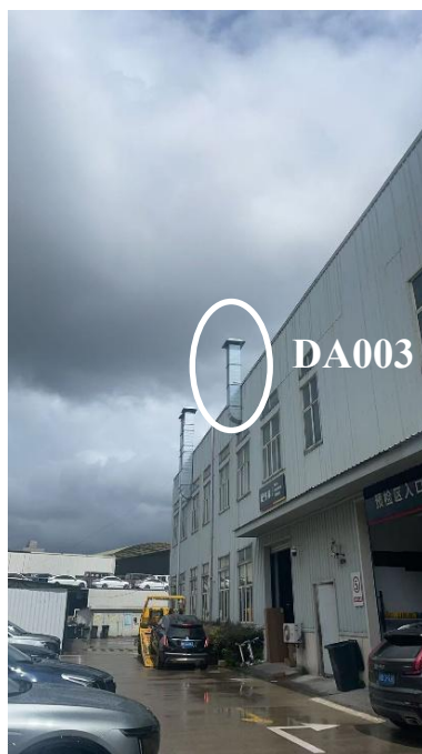
废气排气筒 DA003
