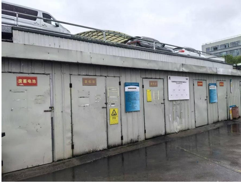
危废仓库现场照片
