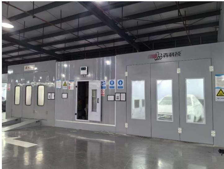
烤漆房（左侧第一阶段已验收，右侧为第二阶段建设）
